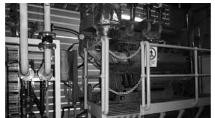
トリジェネレーション設備
