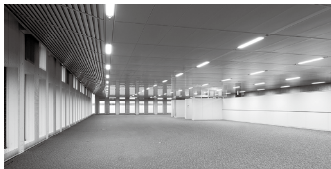
写真1 放射天井パネル
