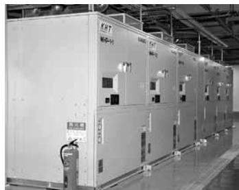
写真(右) INVスクリュウ式ヒートポンプ 写真(左) 密閉式ヒーティングタワー
