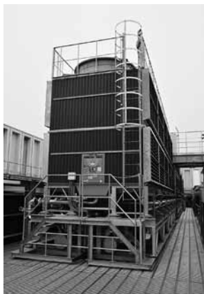
写真(右) INVスクリュウ式ヒートポンプ 写真(左) 密閉式ヒーティングタワー
