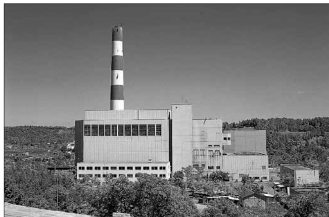
写真1 駒岡清掃工場
