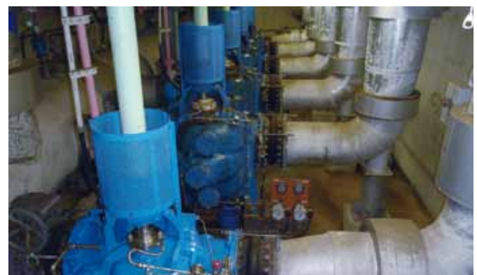
海水取水ポンプ
