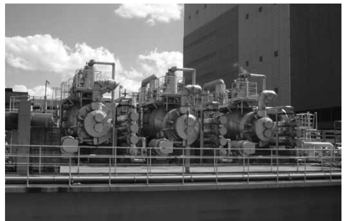
蒸気発生設備
