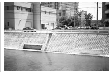
取・放水口設備
