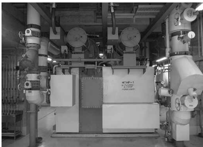
ヒーティングタワーヒートポンプ
