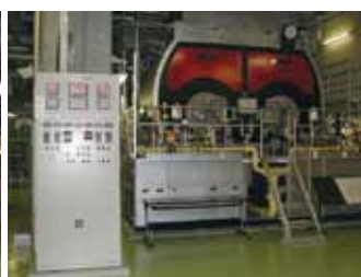
炉筒煙管ボイラー(23t/h)
