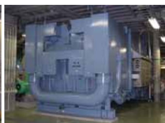
蒸気二重効用吸収式冷凍機
