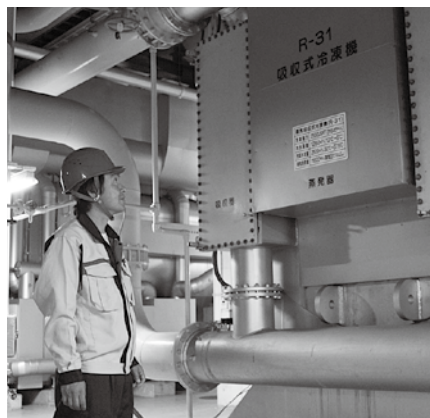
日々の巡回点検では設備の不具合の早期発見などを強く意識
