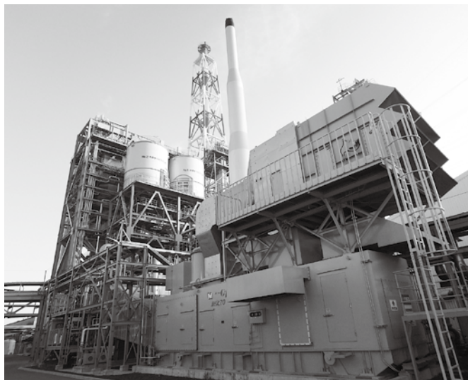
バイオマス発電設備とガスタービン発電設備
