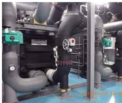
ささしまライブ24地域における下水再生水活用のための熱交換器
