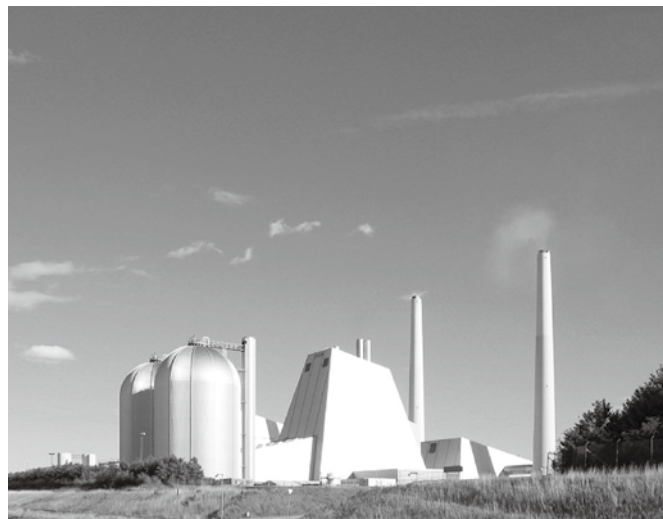
写真1 アヴェドアプラント (Avedøre Plant) にある大規模短期間蓄熱タンク・アキュムレーター（出典：State of Green）
