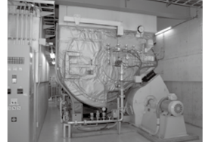
炉筒煙管式ボイラ
