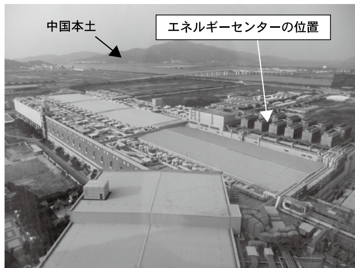
ヴェネチアン・マカオのエネルギーセンター外観
