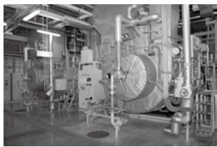
■炉筒煙管式蒸気ボイラ
