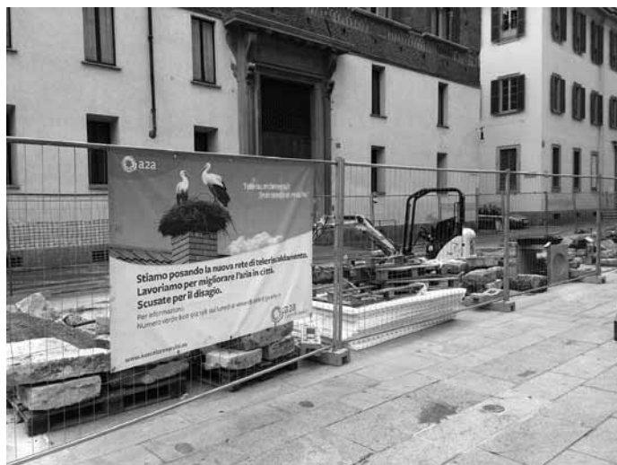
写真3 ミラノ市大聖堂ドゥオーモ横の熱供給配管工事 看板のイタリア語訳：「新しい地域熱供給ネットワークを入れています。不便をおかけし申し訳ありませんが、私たちは街の空気を改善するために働いています。」街の空気を汚す煙突が不要になりコウノトリの巣になって幸せを運ぶというイメージの写真か？
