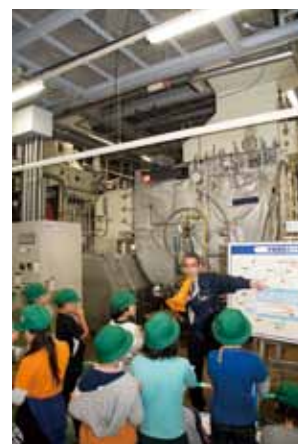
ボイラーの説明
