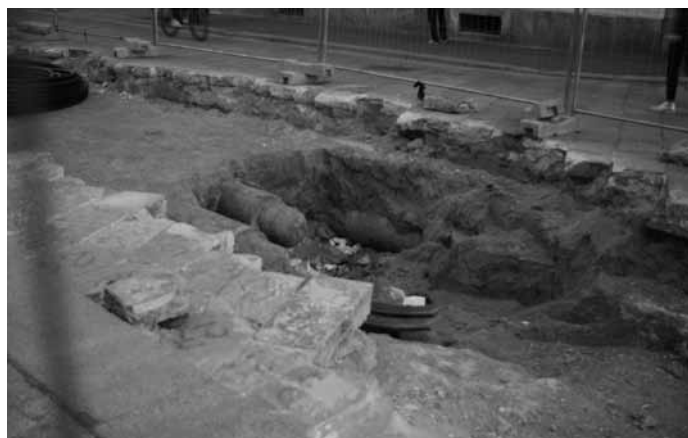
写真4 ドゥオーモ工事現場
