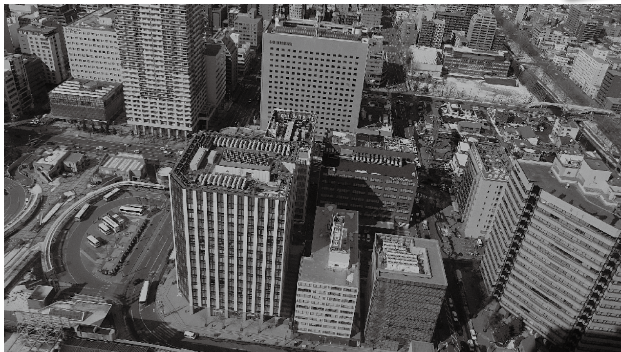
札幌駅北口再開発地域
