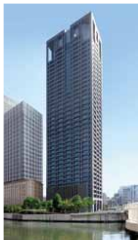
関電ビルディングと中之島二・三丁目熱供給センター河川水取水口
