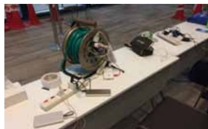
2F市民交流プラザに設けた充電スポット(写真提供:いずれも札幌市)
