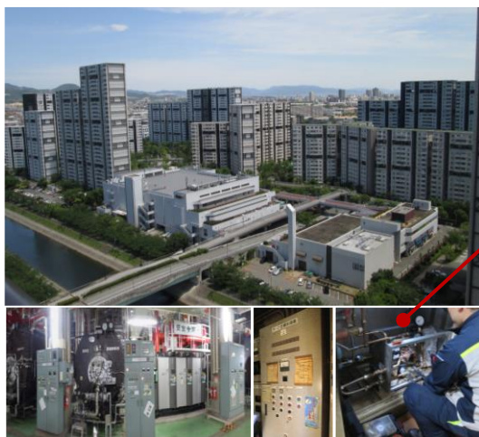
住戸内熱設備修理
