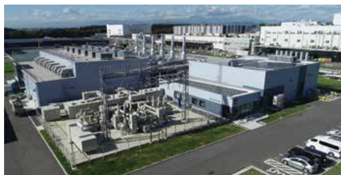
清原スマートエネルギーセンター外観写真
