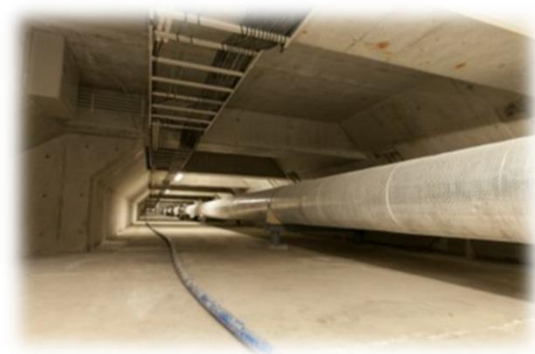
チカホピット内の熱導管の整備
