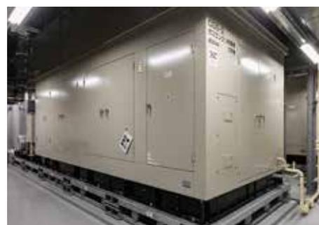
ガスエンジンコージェネレーションシステム (800kW×2基)
