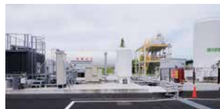
東京ガス横浜テクノステーションにおける鶴見メタネーション実証プラント
