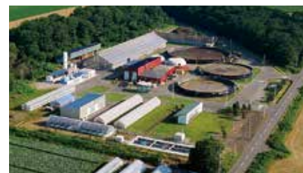
中鹿追バイオガスプラント
