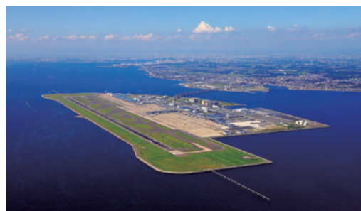
中部国際空港エネルギー供給 中部国際空港島地域
