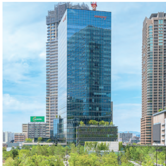
グラングリーン大阪 北館
