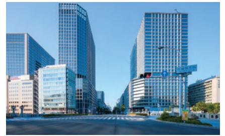
淀屋橋駅の東・西に整備中の再開発ビルと、幅44mの大幹線道路の御堂筋
