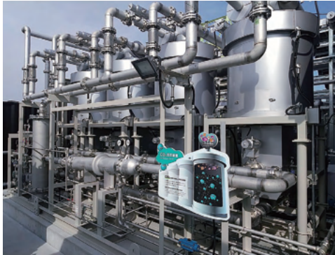
大阪・関西万博「地球の恵みステーション」のCO 2 回収装置(吸収塔)
