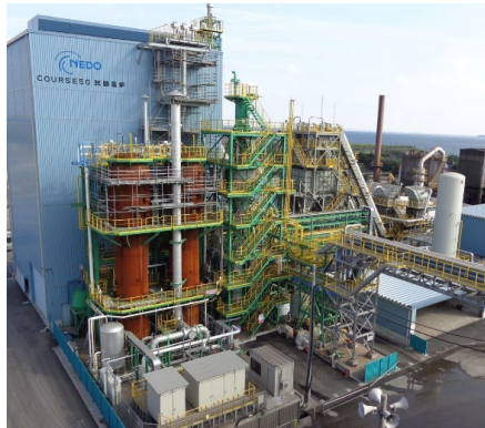
12m 3 小規模試験高炉(水素還元)
