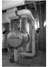
■蒸気発生器 (温水/蒸気・熱交換器)
