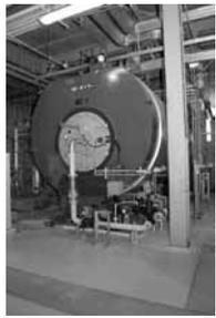
■炉筒煙管式ボイラ (18t/h)
