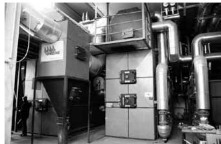
写真1 バイオマス地域熱供給のチップボイラー(5MW+3MW)
