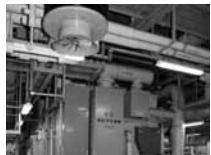
■蒸気吸収式冷凍機
