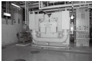
■蒸気二重効用吸収式冷凍機
