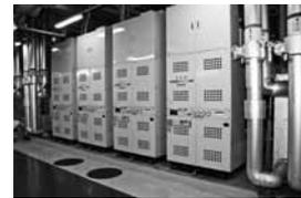
水熱源スクリーンヒートポンプ (製氷型、熱回収型)
