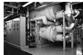
水熱源スクリーンヒートポンプ (製氷型、冷温切替型)
