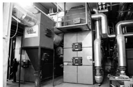
写真1 バイオマス地域熱供給のチップボイラー(5MW+3MW)
