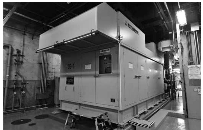
写真1 ガスエンジンCGS 700kW
