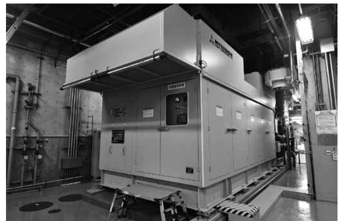
写真1 ガスエンジンCGS 700kW
