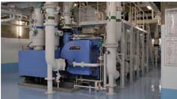
東池袋地区では、設備更新期に「熱媒過流量制御ターボ冷凍機」を導入しました。従来のターボ冷凍機は、冷熱負荷が小さい時、冷水の行き・還り温度差が小さくなることで、余計に冷水流量が必要となって稼働台数が増えてしまいますが、この熱媒過流量制御ターボ冷凍機であれば、稼働台数を増やさずに効率よく冷水を製造することが可能になります。同地区では、プラント全体の再構築とあわせ、約36%の省エネルギー化\*を実現することができました。
