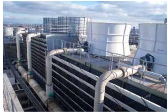
札幌駅北口再開発地区では、冬季に冷凍機を使用せずに、外気温を活用して、冷却塔だけで冷水製造を行なうという「フリークーリングシステム」という技術を採用しています。このシステムを活用するのは、外気温が9℃以下の時期。電動ターボ冷凍機で冬季も冷水供給を行っていた同地区では、2011年度実績で、386,088kWh/年の電力使用量削減効果がありました。
