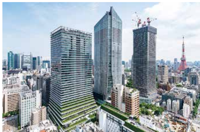
虎ノ門ヒルズビジネスタワー 外観
