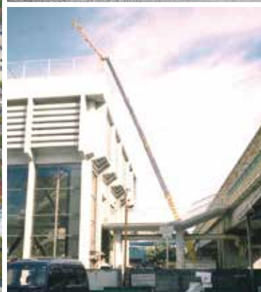
(左) 泉北泉ヶ丘地域(2018)。写真中央: センター地区、右上: 旧ヤングタウン地区 (右上) 泉ヶ丘駅前広場とエネルギーセンター(1970) (右下) 冷却塔更新工事(2002)。1970年時の写真のようなスペースが周囲になく、クレーン車が届かない箇所が増え、屋上設備の工事が難しくなった
